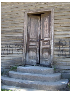
Puerta acceso antigua Pulpería MH Soc. Industrial del Aysen (foto: Núcleo de Antropología Aplicada)
